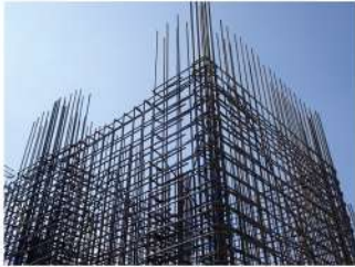
เหล็กเสริมคอนกรีต
